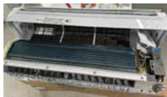
3. Retire la tapa desinstalando estos 10 tornillos.
