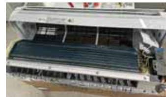
3. Enlevez le couvercle en retirant ces 10 vis.
